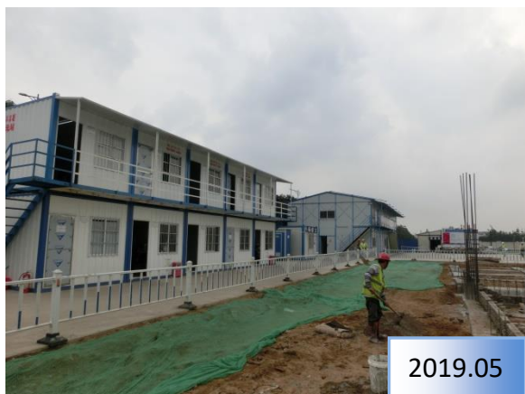
施工期，施工临建区建设
