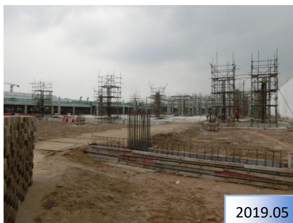
施工期, 地基建设
