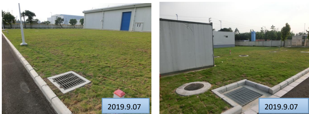
本项目道路旁雨水口现状
