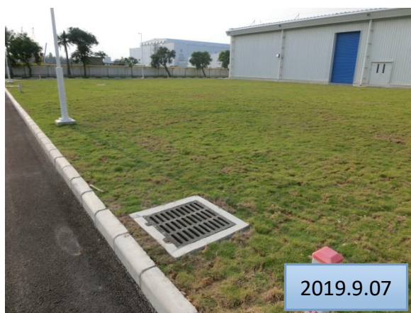
本项目道路旁雨水口现状
