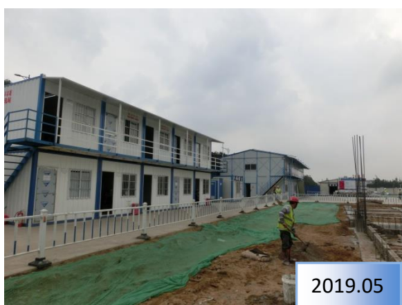
施工期, 施工临建区建设
