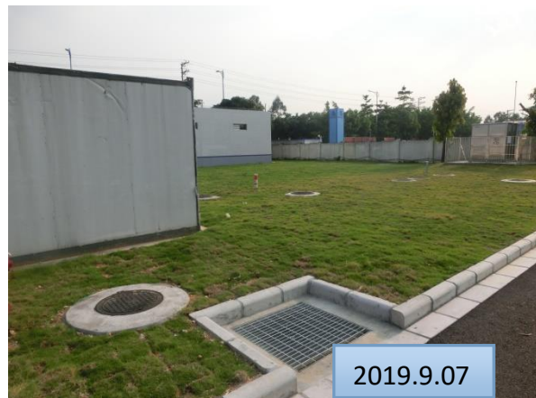
本项目道路旁雨水口现状
