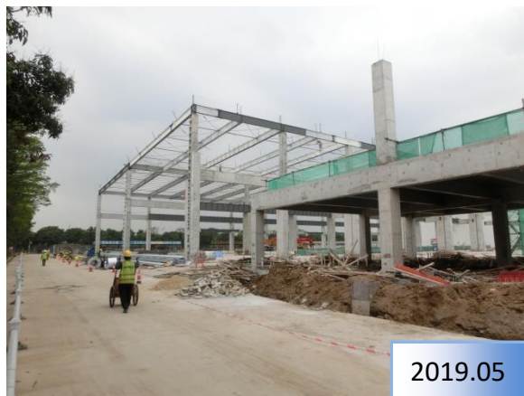
施工期，开挖管线沟槽
