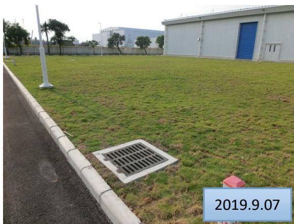
本项目道路旁雨水口现状
