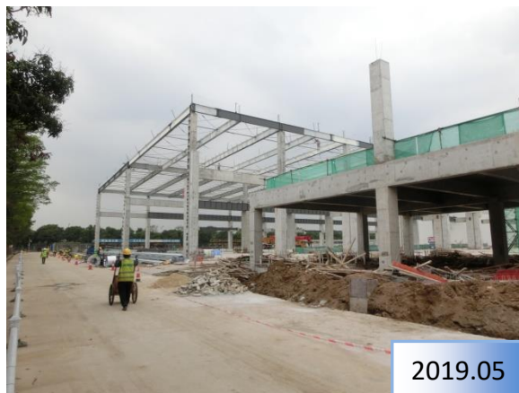
施工期, 开挖管线沟槽
