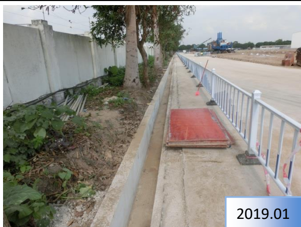
场区临时排水沟
