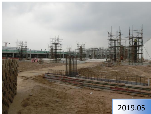
施工期，地基建设
