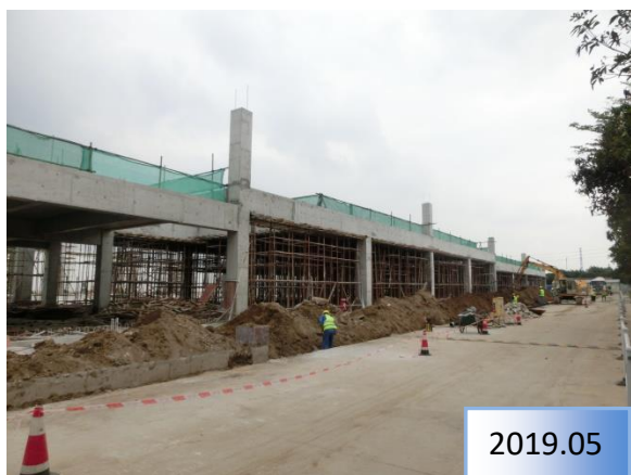
施工期，开挖管线沟槽
