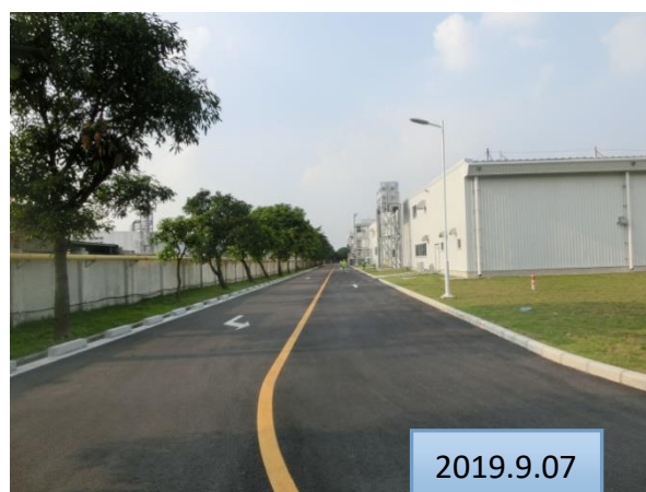
本项目道路旁绿地现状
