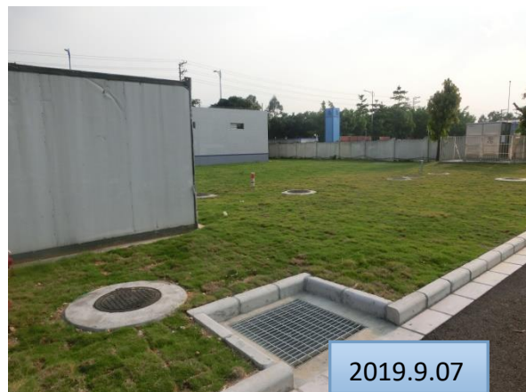
本项目道路旁雨水口现状
