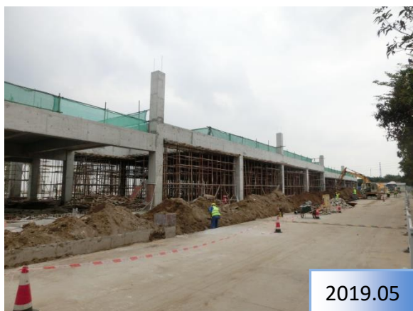
施工期, 开挖管线沟槽
